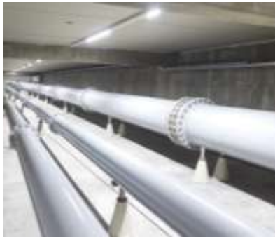
Abbildung 11: Rohrleitungsgebäude mit Mischstrecke
