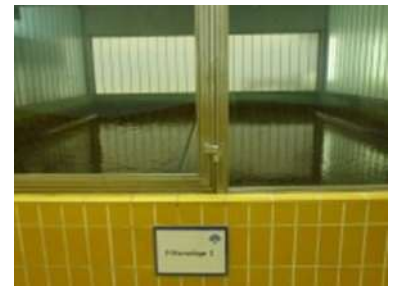
Abbildung 10: Quarzsandfilter
