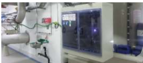
Abbildung 14: Dosieranlage
