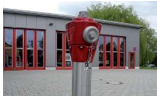
Abbildung 25: Oberflurhydrant
